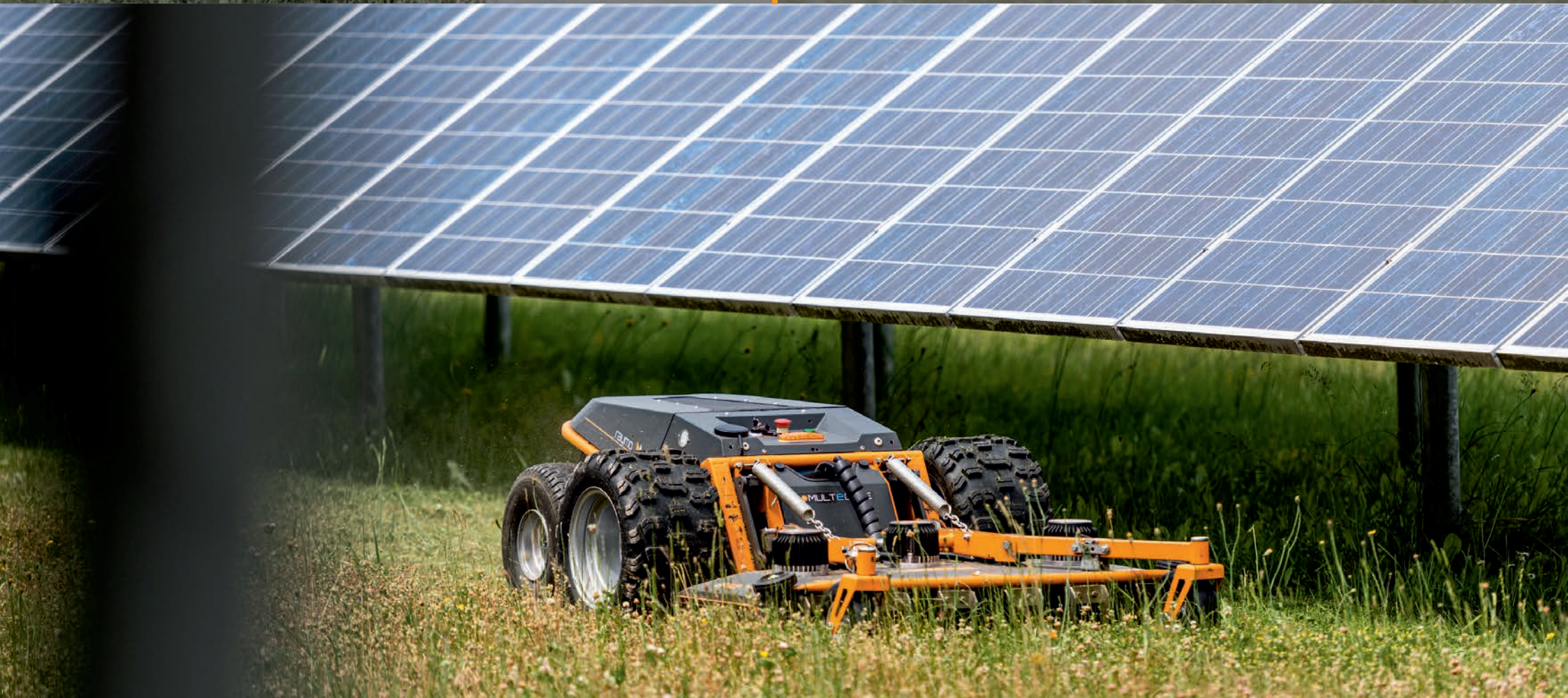
Umspannungswerke / Energy Parks / Solarpanelflächen
